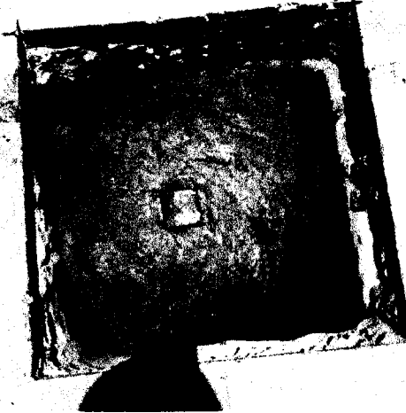
IMAGEN 19 Solado de concreto
