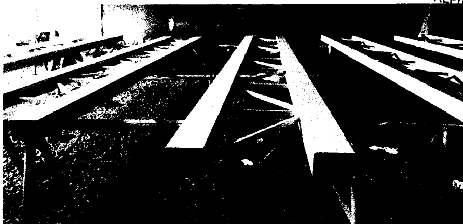
IMAGEN 33 Granallado de Vigas perimetrales
