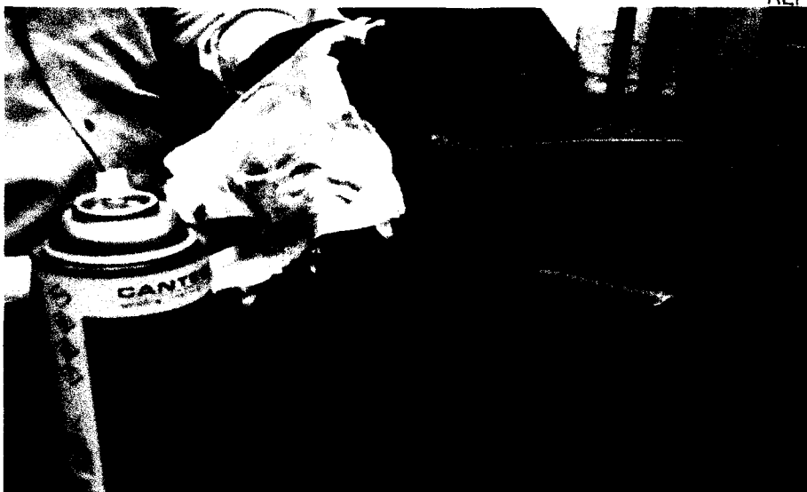
IMAGEN 30 Prueba de soldadura –Limpieza del líquido penetrante
