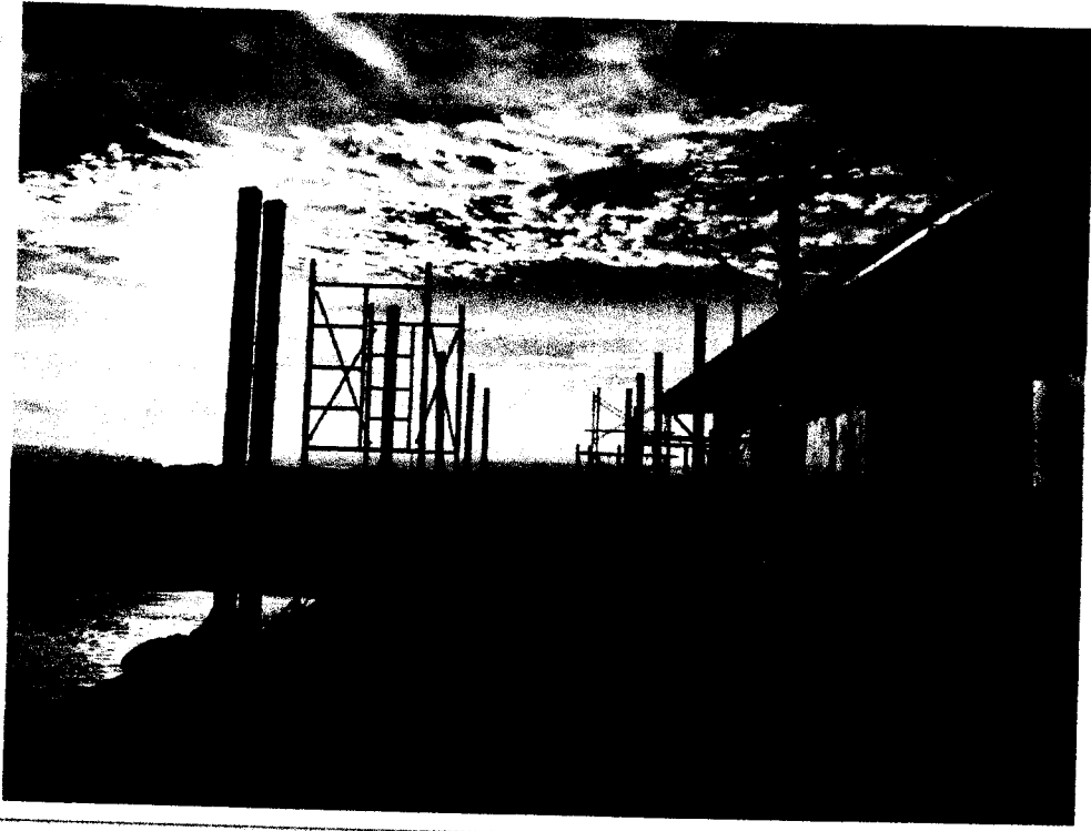
Izaje de parantes metálicos sobre pedestales
