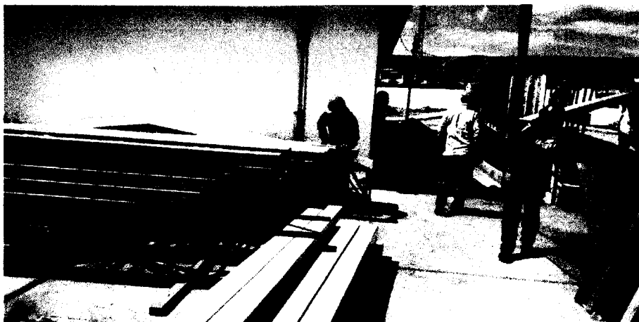
IMAGEN 39 Descarga de estructura en muelle
