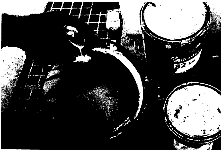
IMAGEN 11 Preparación del Sikadur 32
